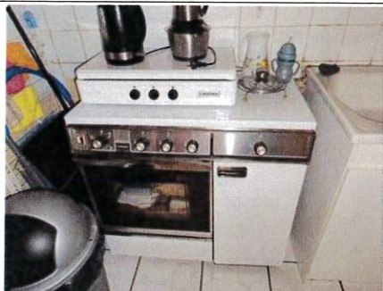
Photo n° PhGaz002 Localisation : Cuisine Cuisinière FAGOR (Type : Non raccordé)
