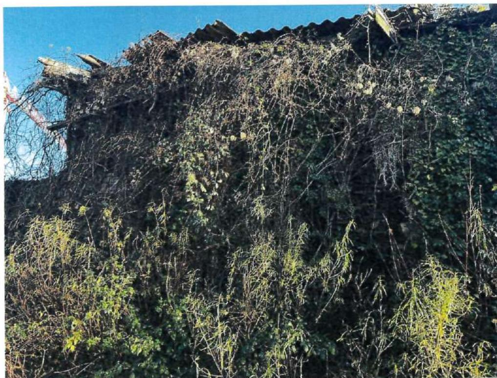
Je constate également qu'il n'y a aucun entretien de la végétation et que la toiture ondulée type fibrociment est fortement dégradée.
